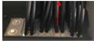
Fig. 21: DC-Leitungen in Kabeldurchführung einführen
